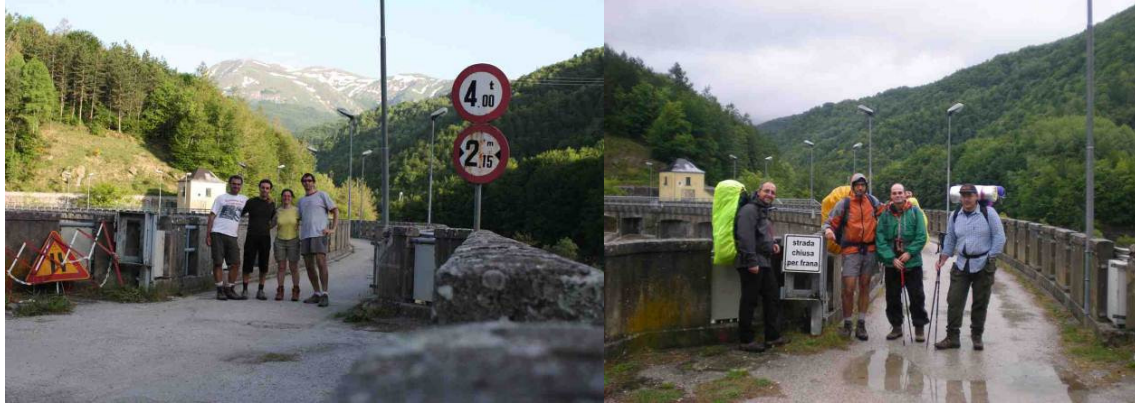
(Diga della Provvidenza, 24 maggio 2009, 11 settembre 2010)
